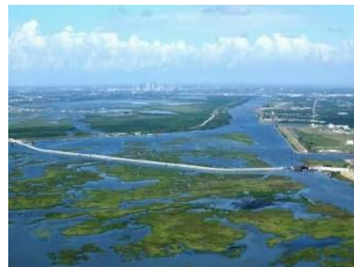
写真 1 IHNC ボーン湖防潮堤全景 17
