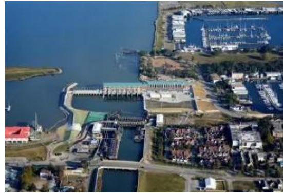
写真 2 17 番街運河ポンプ場全景 19
