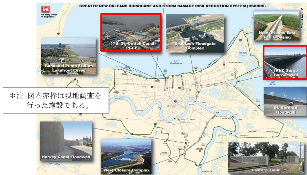
図 5 HSDRRS で整備された施設 15
