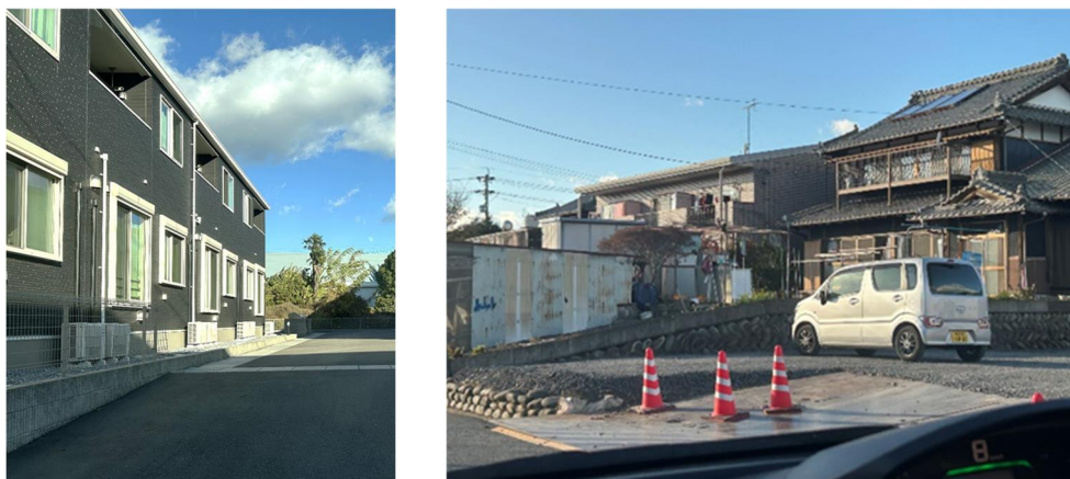
写真 1 かさ上げの様子 13
