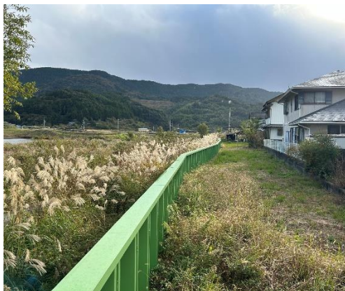
写真 5 日高村が整備した輪中堤 60
