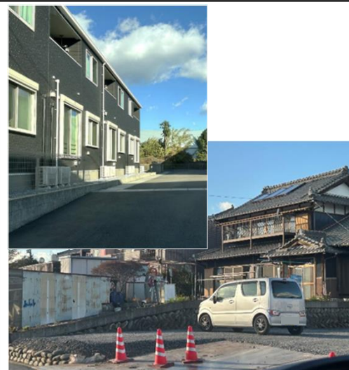
【美濃加茂市】住宅のかさ上げの様子 上：市の補助金が交付された住宅（建替え） 下：元々かさ上げがされていた既存の住宅
