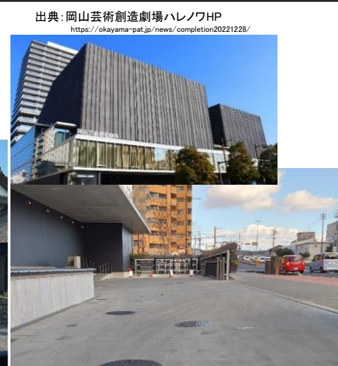
【岡山市】雨水貯留施設が 地下に設置された市施設 上：岡山芸術創造劇場ハレノワの外観 下：敷地から建物側へつけられた水勾配
