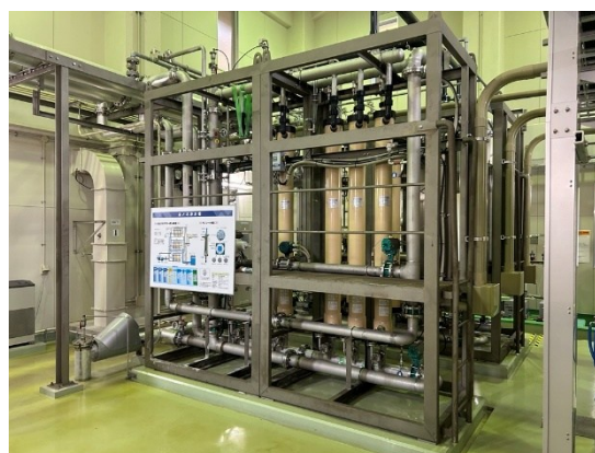
写真1 水土野水源の湧水(左)と品ノ木浄水場の膜ろ過処理施設(右)
