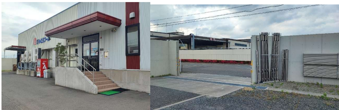
図－10. (株)いとうフーズの社屋兼工場建屋(左)と止水壁(右)
