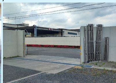
止水壁整備 ㈱いとうフーズ(肉加工品製造)
