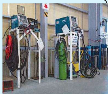
溶接機器のかさ上げ ㈱羽田工業所(製缶板金)
