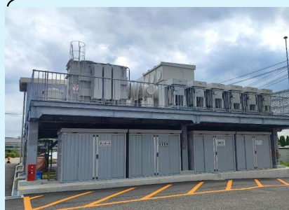
特別高圧変電所のかさ上げ 信越石英(株)(石英ガラス製品製造)
