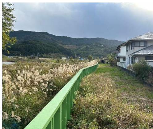
写真 5 日高村が整備した輪中堤 60
