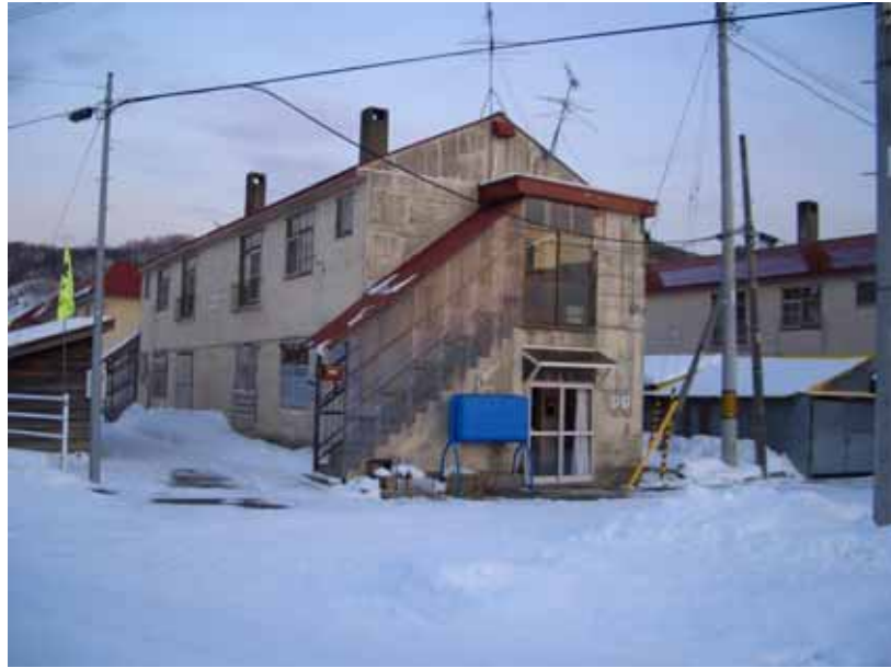
図 - 4 産炭地の公営住宅（夕張市）
