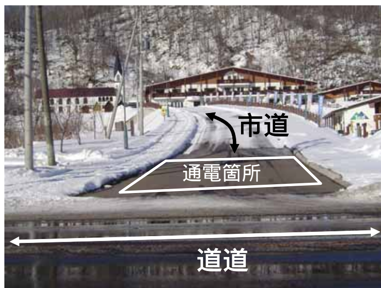
図 - 3 ロードヒーティングの一部通電停止事例(歌志内市中村地区) 交差点手前のみ通電を行っている。
