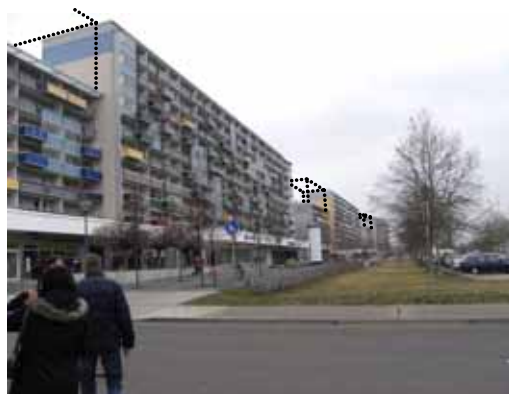
図 - 8 集合住宅の部分撤去(コットブス ザクセンドルフ地区 / 波線部分を撤去)
