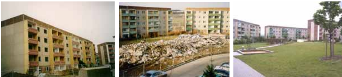
図 - 7 プレハブ住宅の解体 (左:解体前、中:解体中、右:解体後) 20
