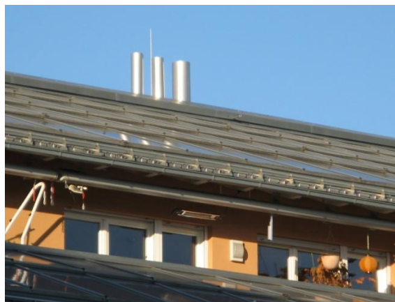
図表 10 Ackermannbogen 地区の太陽熱利用地域暖房システム
