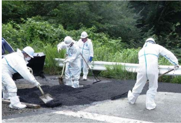
保護衣着用での国道6号補修状況（富岡町）
