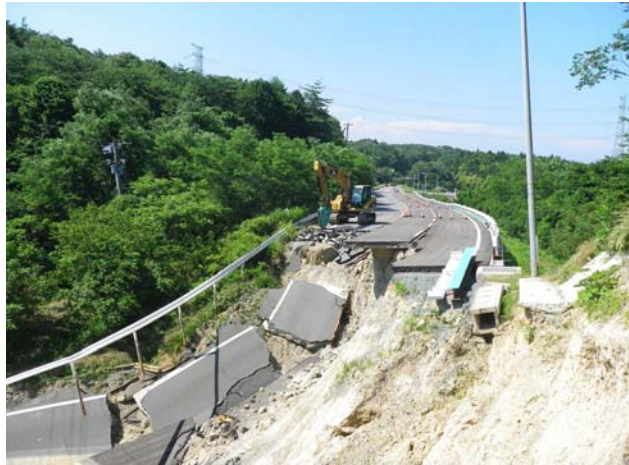
国道6号被災状況（富岡町上郡山）
