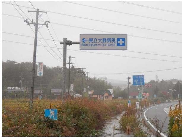
雑草が生い茂った国道6号（大熊町）
