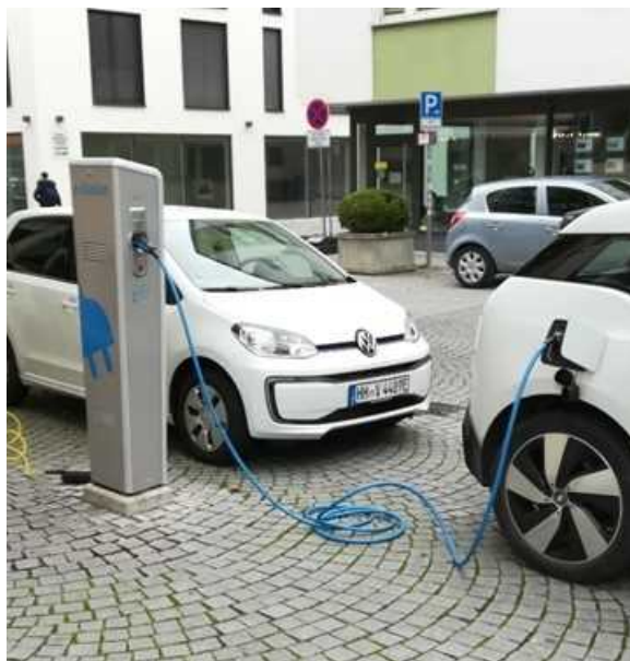
図 10 充電ステーション
