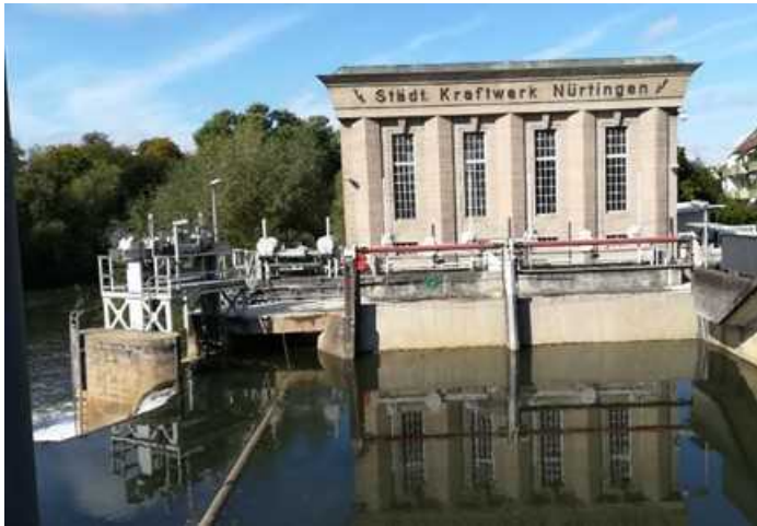
図 4 Stadtwerke Nürtingen の水力発電所
