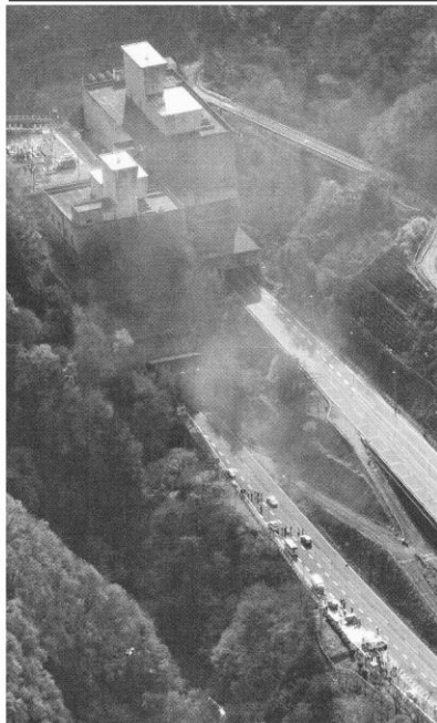
中央自動車道上り線の笹子トンネル入り口で救助活動に当たる消防隊員ら。トンネル内の車両火災で煙が上がる
