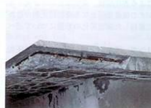
写真-5 剥落・崩壊 ®
