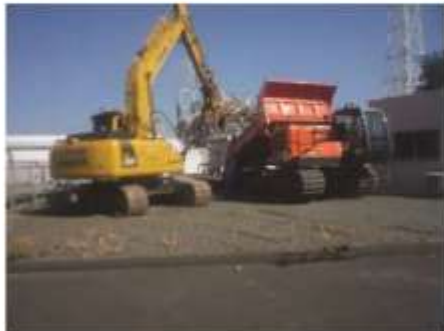
仮置き場定置作業
