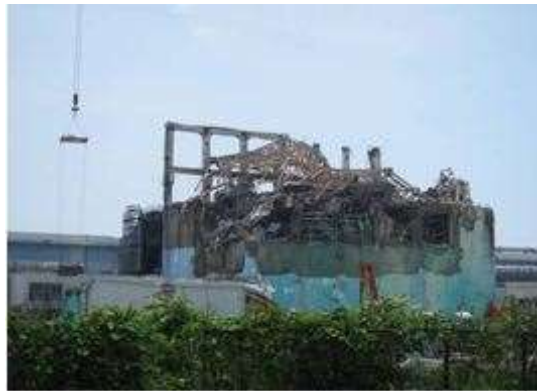
原子炉建屋 解体現場
