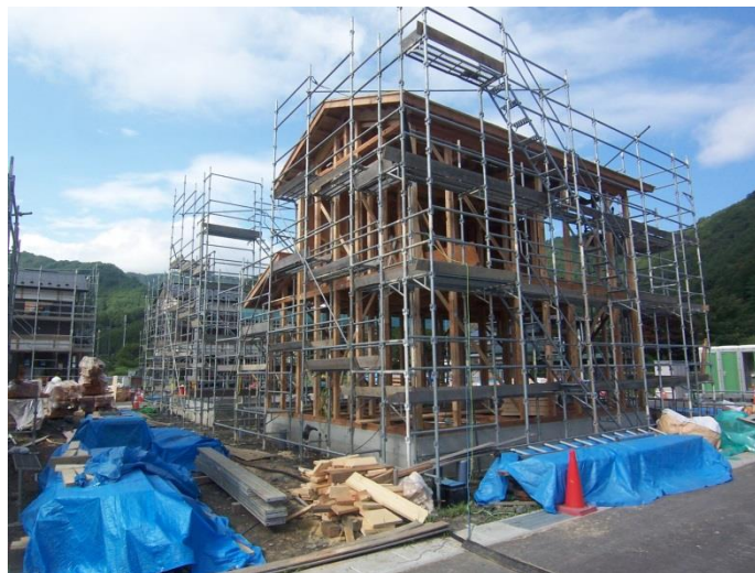
災害公営住宅の建設状況
