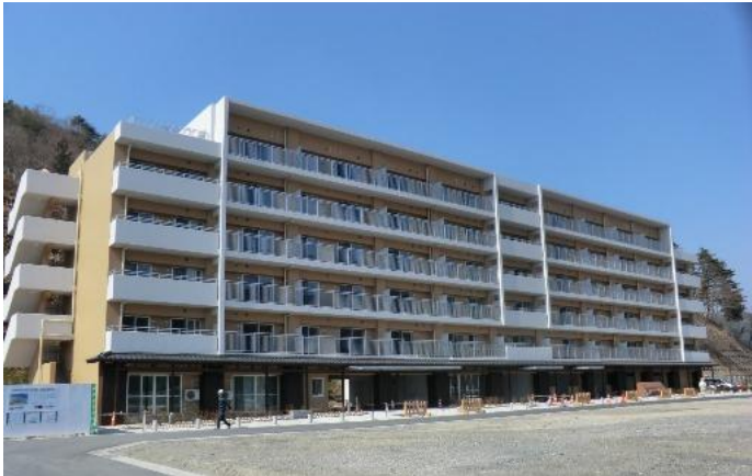
末広町災害公営住宅 H28.03完成
