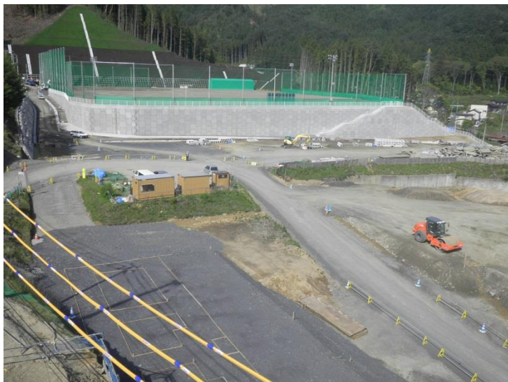
H28.5 大槌学園 工事状況
