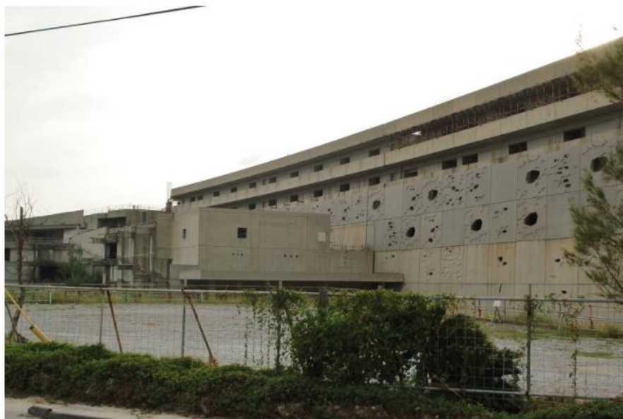
2008年の開発中断以降、工事が止まっている瀬底のリゾートホテル＝本部町・瀬底島
