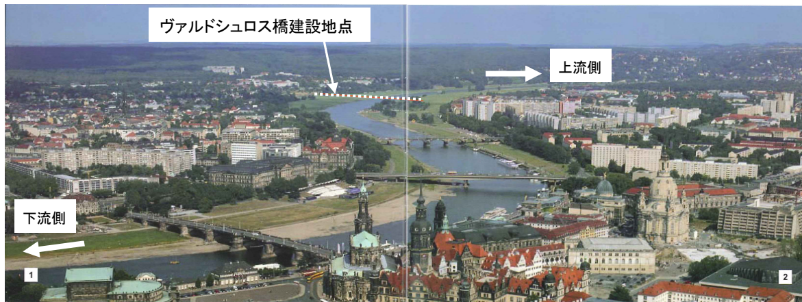
図－8 中心市街地（写真手前）と橋建設地点の状況 2
