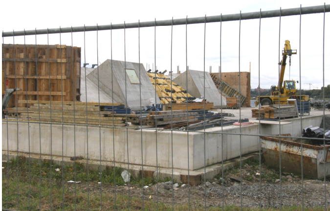
図-9 ヴァルドシュロス橋工事の状況（アーチ橋台）
