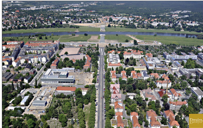
図-2 ヴァルドシュロス橋建設手地点と周辺の状況 写真手前が橋南側の住宅地、奥が建設現場(ドレスデン市提供)
