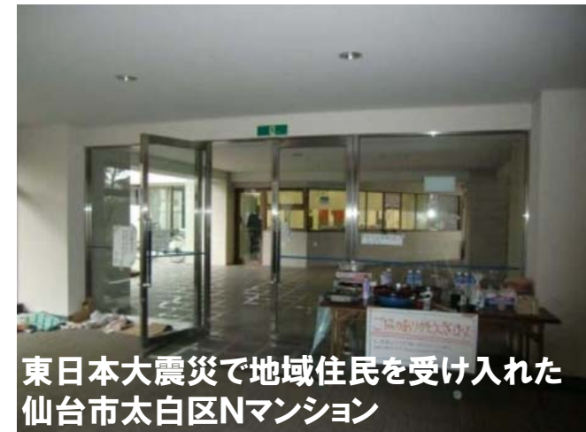
東日本大震災で地域住民を受け入れた 仙台市太白区Nマンション 出典：日本マンション学会(2011)「東日本大震災特別研究委員会被災地調査報告(2011年4月29日～5月1日)」
