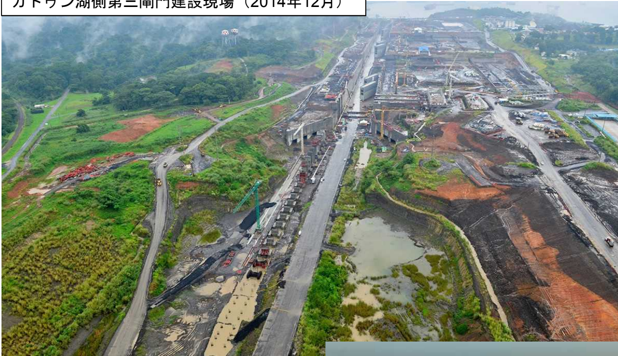
ガトゥン湖側第三閘門建設現場（2014年12月）
