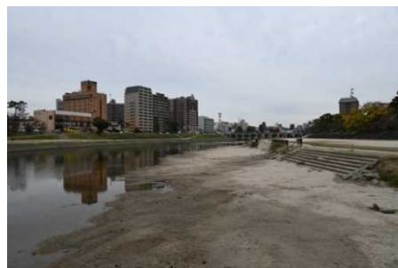
写真6 「乙川河川敷の様子」
