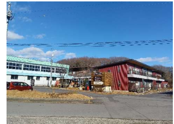
那須まちづくり広場の外観
