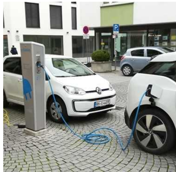
左上: SW運営トラム 右上: SW社屋 左下: 配電網機器 右下: 充電ステーション
