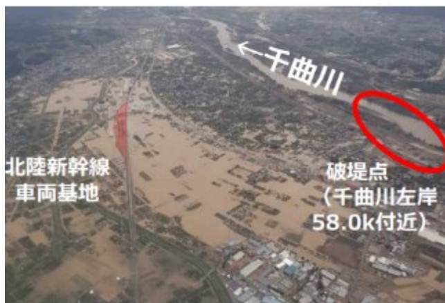
令和元年東日本台風による堤防決壊 (長野県長野市,2019.10)
