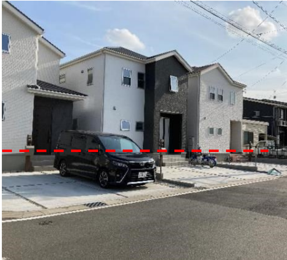
一般住宅での1階部分かさ上げの実施状況
