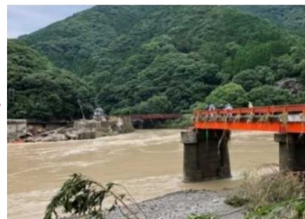
令和2年7月豪雨による橋梁流出 (熊本県八代市,2020.7)
