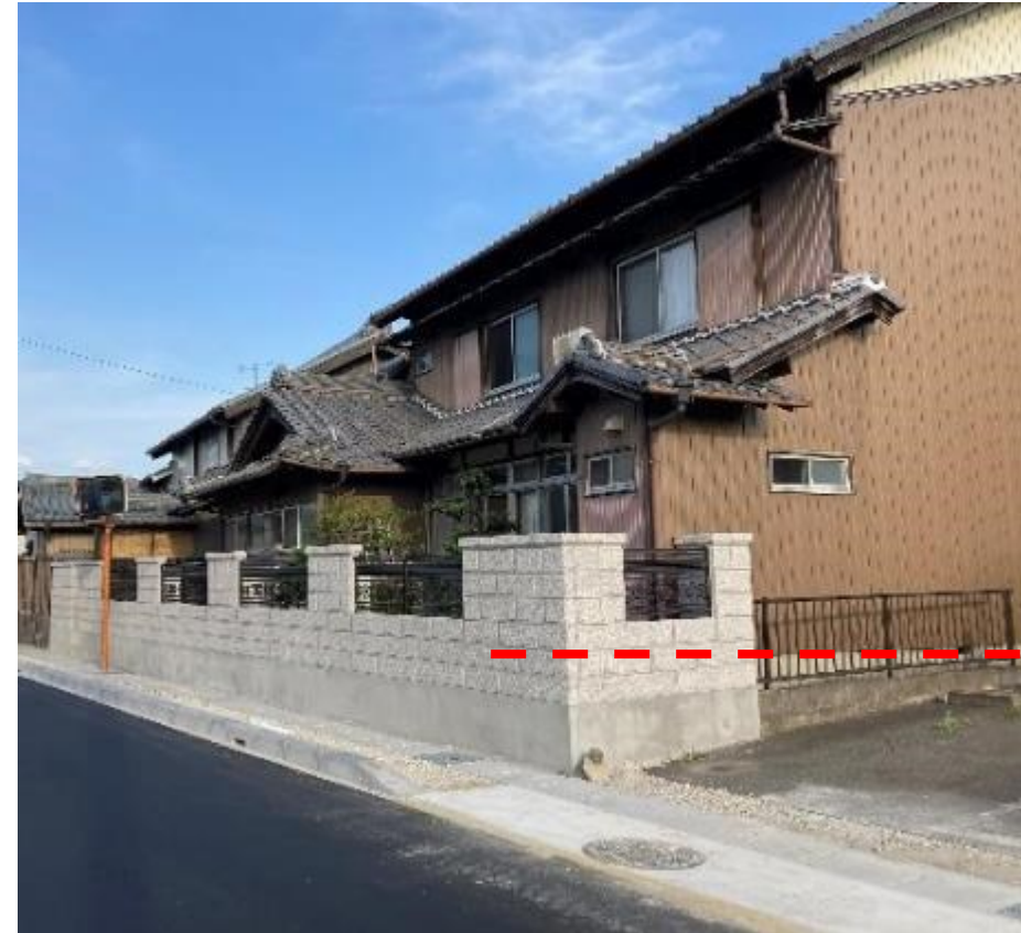
一般住宅での1階部分かさ上げの実施状況
