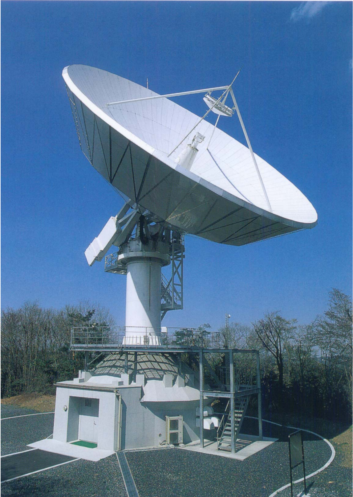
CDAS 新アンテナ (気象衛星通信所)
