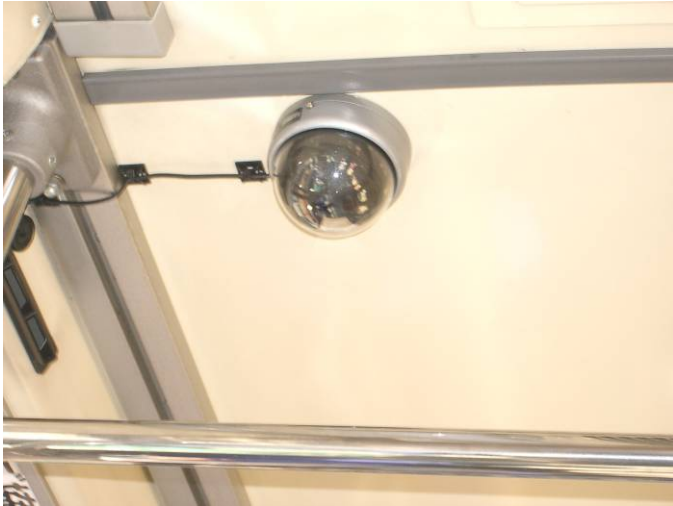
写真4 バス社内天井に取り付けられた監視カメラ
