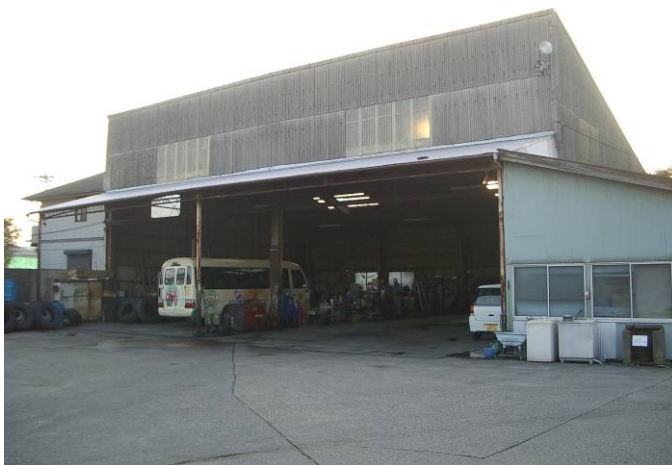
写真 3 整備工場風景
