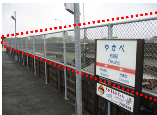
新設されたアルミフェンス
