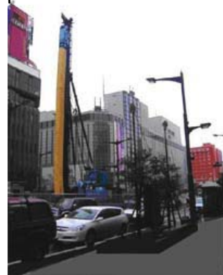
&lt;すすきの駅の工事&gt;
