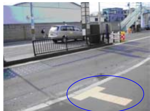
<誘導ブロック設置状況>
