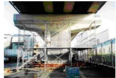
&lt;橋脚の補強工事&gt;
