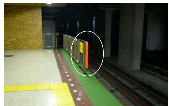
<反射テープ貼付け状況>
