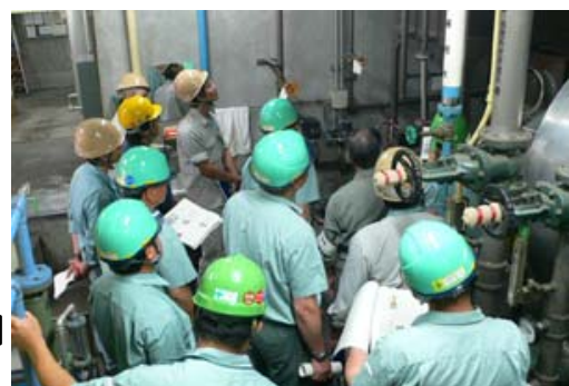
<ボイラー用重油漏洩時のバルブ操作訓練>
