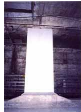
開削トンネルの中柱補強
