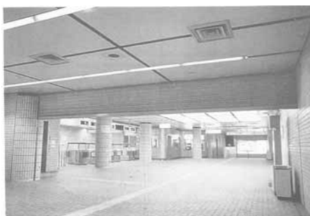
防火シャッター
