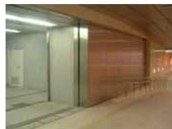
他施設との連絡通路 における止水鉄扉
