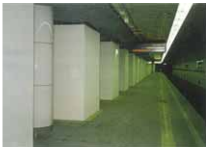
三宮駅復旧状況 (B3Fプラットフォーム仮支柱養生)
