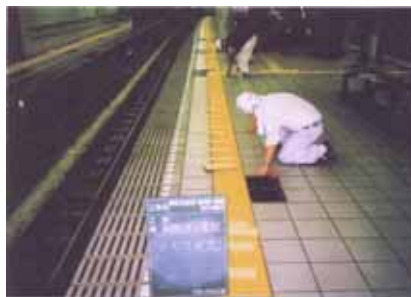
バリアフリー改修
