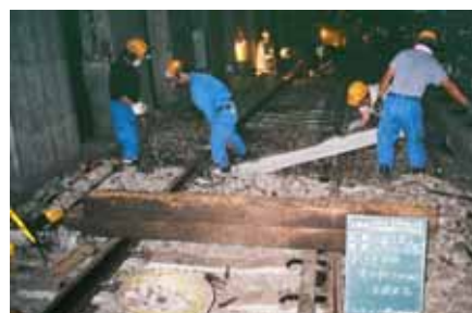
まくらぎ交換工事
