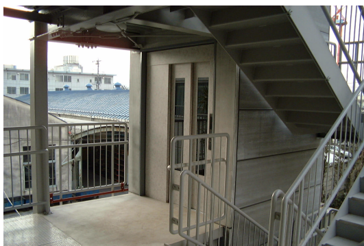
既存外廊下に増築したEV棟 外階段と一体化している
