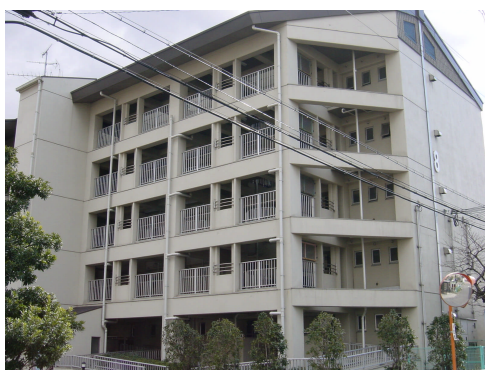
増築部分を北側から見たところ
