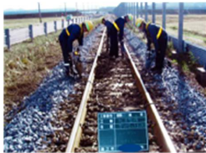
レールの修繕
