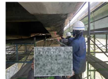
修繕の様子(断面修復)
