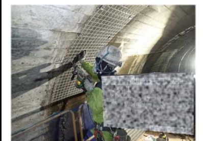
修繕の様子(剥落対策)
