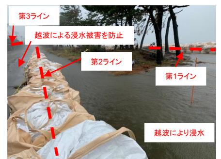
土嚢を3列に配置し浸水被害を防止(10月12日撮影)
