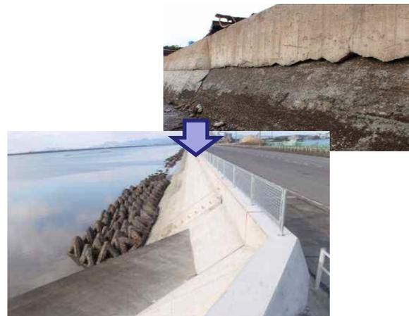
波浪による洗掘からの堤体陥没を防ぐため、脆弱部の補修・補強を実施
