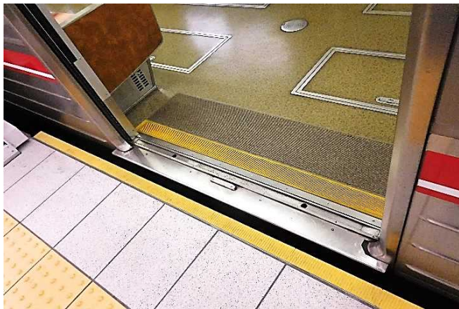
櫛ゴムによる隙間解消
