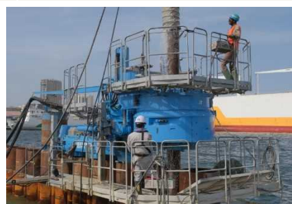
セネガルでの施工の様子
