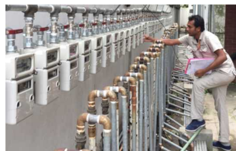
プリペイド式ガスメーターと設置作業(バングラデシュ)
