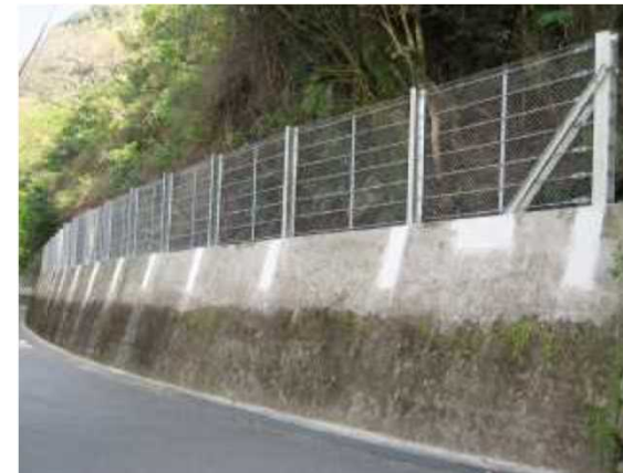
落石防護柵工(イメージ)
