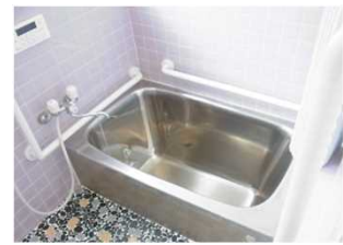
○バリアフリー改修 浴室手摺取付
