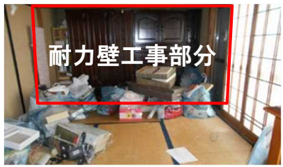
○改修前 1階和室6帖
