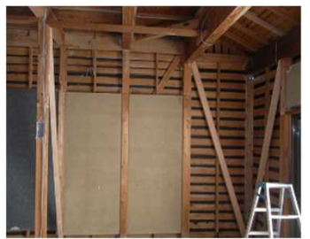
○筋交い設置(耐力壁)
