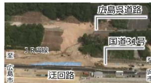
広島県道路・国道31号の被害状況
