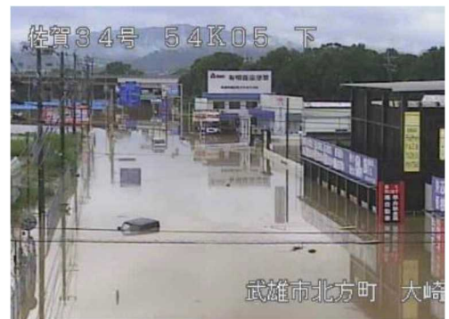
国道 34 号の浸水状況（佐賀県武雄市 たけお ）
