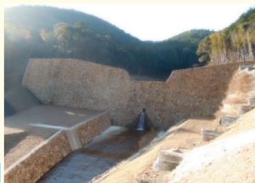
那智川水系鳴子谷川 砂防堰堤
