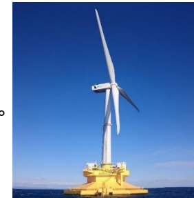
浮体式洋上風力発電設備
