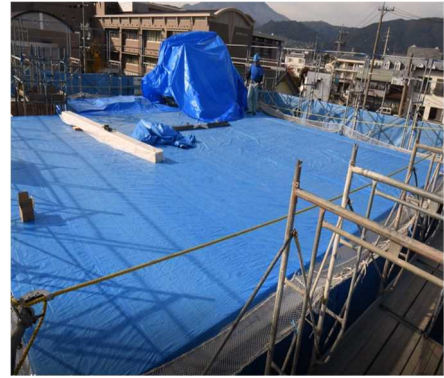
写真-3 床の養生の例
