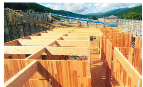
写真 6-2 建方時シートをたたんだ状態
