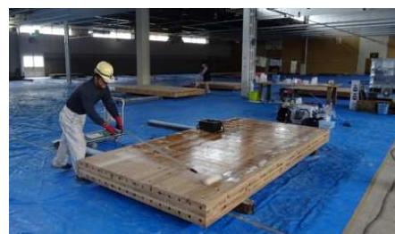
写真-8 CLT 床版防蟻処理の例
