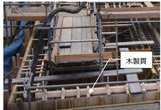
写真-4 上部に木製貫を使用した例
