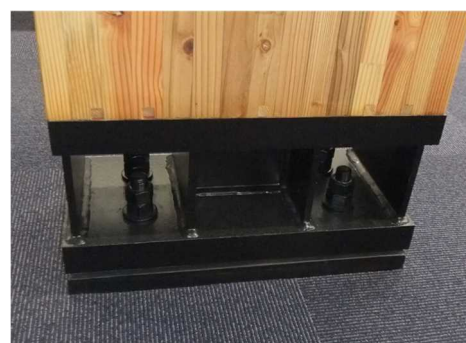
写真-9 接合部を露出させた例(柱脚部)
