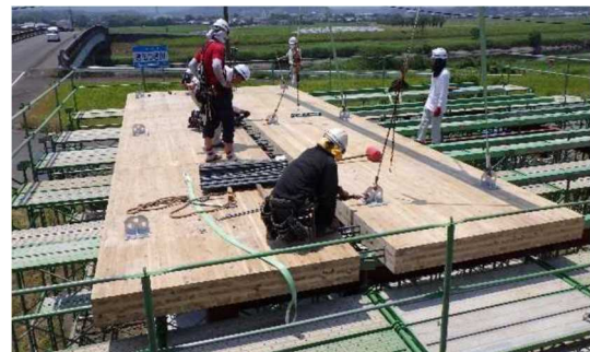
写真-14 CLT の版合体(2m×10m 版)の例
