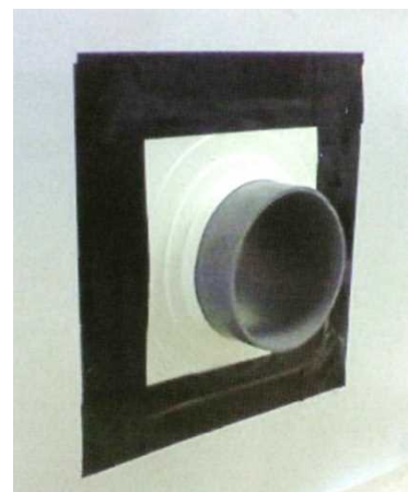
写真-5 気密テープの施工状況※1
