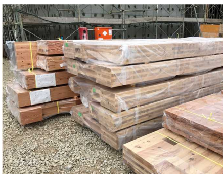
写真-3 工事現場での集積状況
