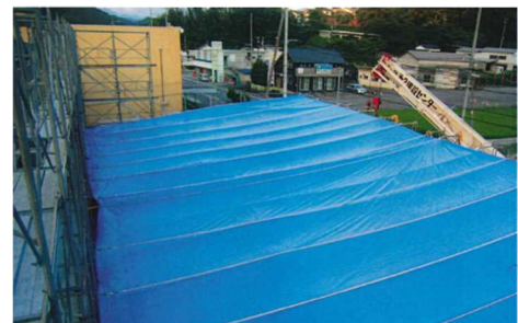
写真 6-1 雨対策としてシートを閉じた状態
