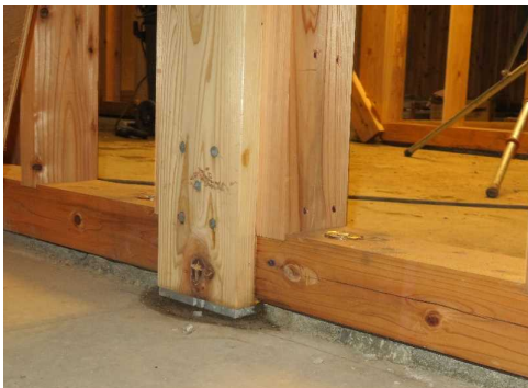
写真-1 柱脚金物によるアンカーボルトと柱の緊結例
