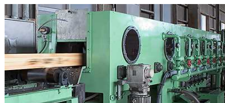
写真-9 深浸潤処理 (薬液吹付装置)
