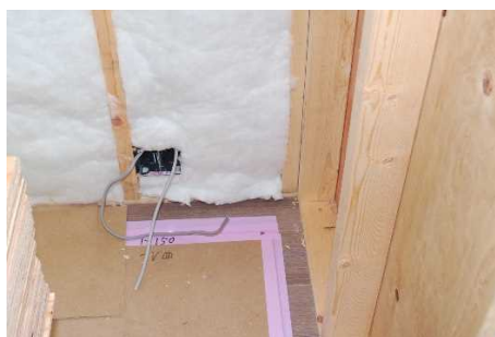
写真-3 断熱材の充填状況(その2)※2
