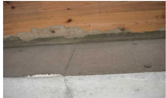
写真-8 同左コンクリート打設確認の例
