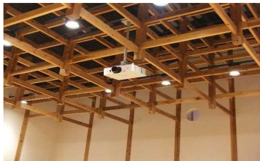
写真-2 伝統工法による架構の例
