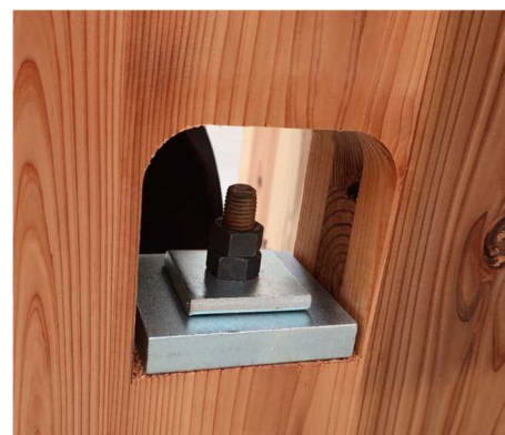
写真-7 引抜きボルトの開口部の例
