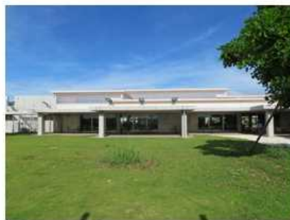
出発ラウンジ棟外観 (滑走路側より)
