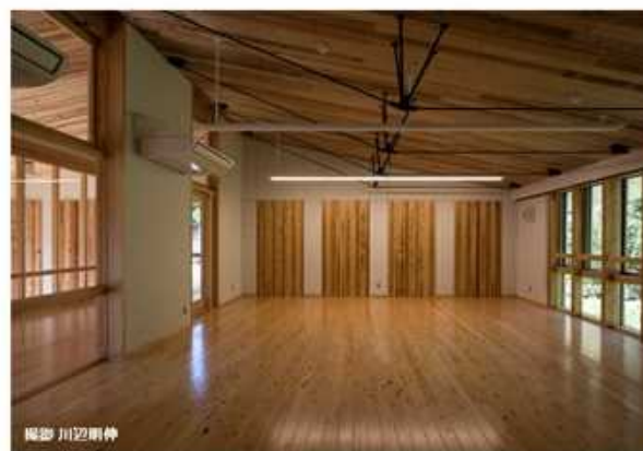
CLTを使用した教室
