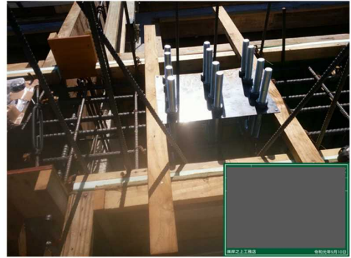
写真-2 テンプレート使用例
