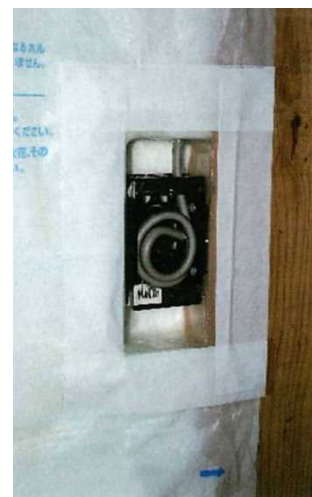
写真-4 気密テープの施工状況※1
