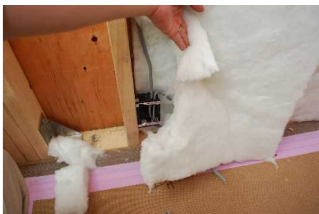
写真-2 断熱材の充填状況(その1)※2
