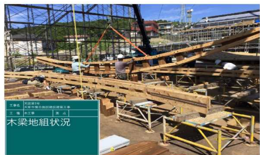
写真-10 重ね透かし梁の地組の例
