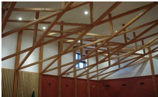
写真-1 流通小径製材による架構の例
