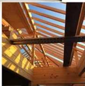
小屋組の状況（工事中）
