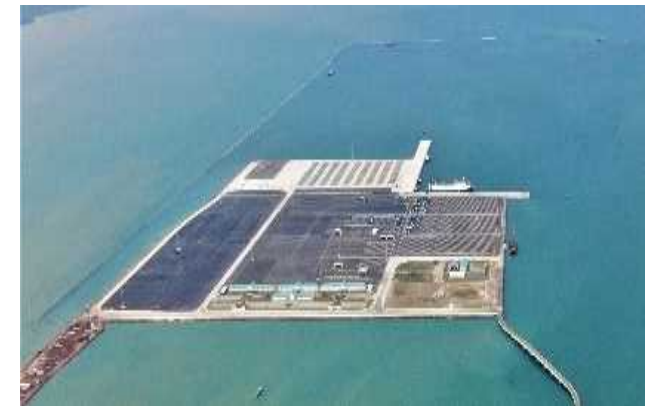
パティンバン港の整備状況 (東洋建設提供)
