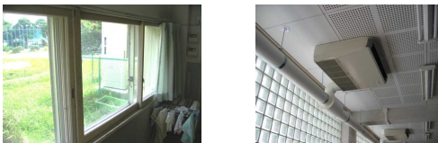
学校等の防音工事(防音サッシ・空調機)
