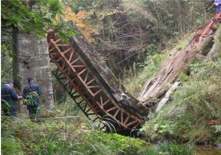
写真 2-1 老朽化が原因で落橋した国内事例1
