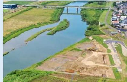
流域治水の基盤となる河川整備が全国で着実に進められています。令和3年度には約1,400万㎡（10tダンプ約280万台分）の河道掘削（国管理区間）が行われるなど、地域の安全の確保に取り組んでいます。
