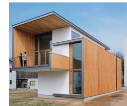
CLT工法による実験棟
