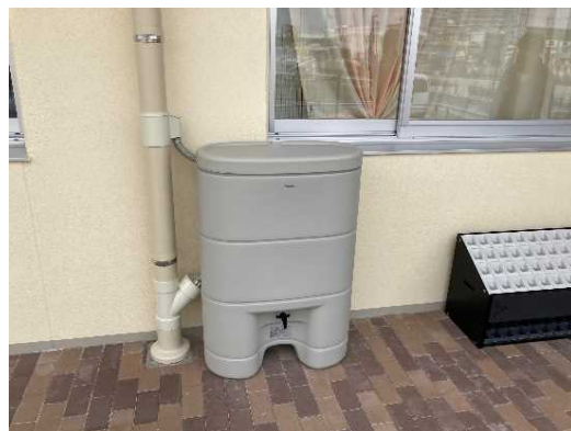
雨水貯留タンクの設置状況
