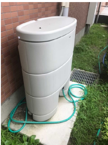
雨水貯留タンクの設置状況
