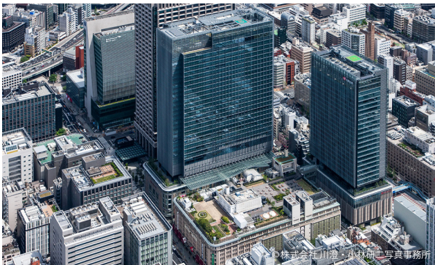
南西側鳥瞰。 手前のB街区、右のA街区、左奥のC街区、その奥に隠れたD街区の一体的開発。
