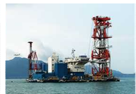
香港国際空港第三滑走路建設 地盤改良工事(第1工区)
