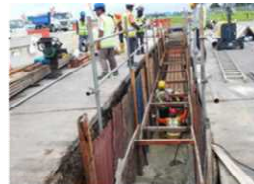
埋設工事の様子
