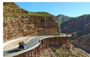
東西道路改修事業(国道70号線)
